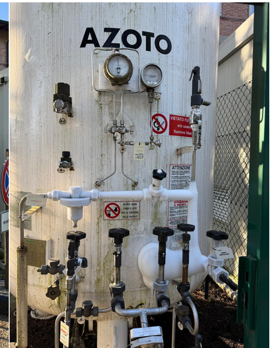
Controllo e apertura valvola dell'evaporatore criogenico
